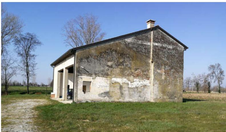
Trattasi di un fabbricato a destinazione agricola attualmente dismesso di circa 1230 mc. Si sviluppa con una pianta di forma quadrata e su due piani. Al piano terra l'edificio presenta un portico che disbriga un locale adibito a stalla e due silos, al primo piano sul solaio della stalla si sviluppa il fienile.
