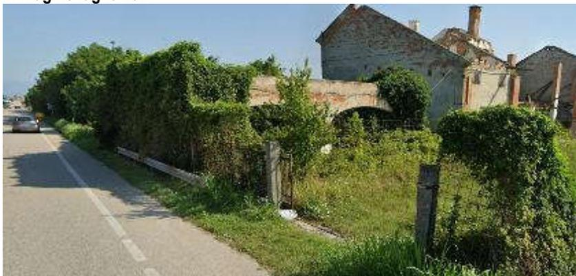
Lo stato di conservazione attuale presenta un avanzato processo di degrado del manufatto di cui non sono più riconoscibili gli aspetti architettonici e testimoniali che ne avevano comportato l’indicazione di tutela; l’edificio è ormai completamente privo della copertura e di tutto il primo piano, che ne costituiva la porzione prevalente.
